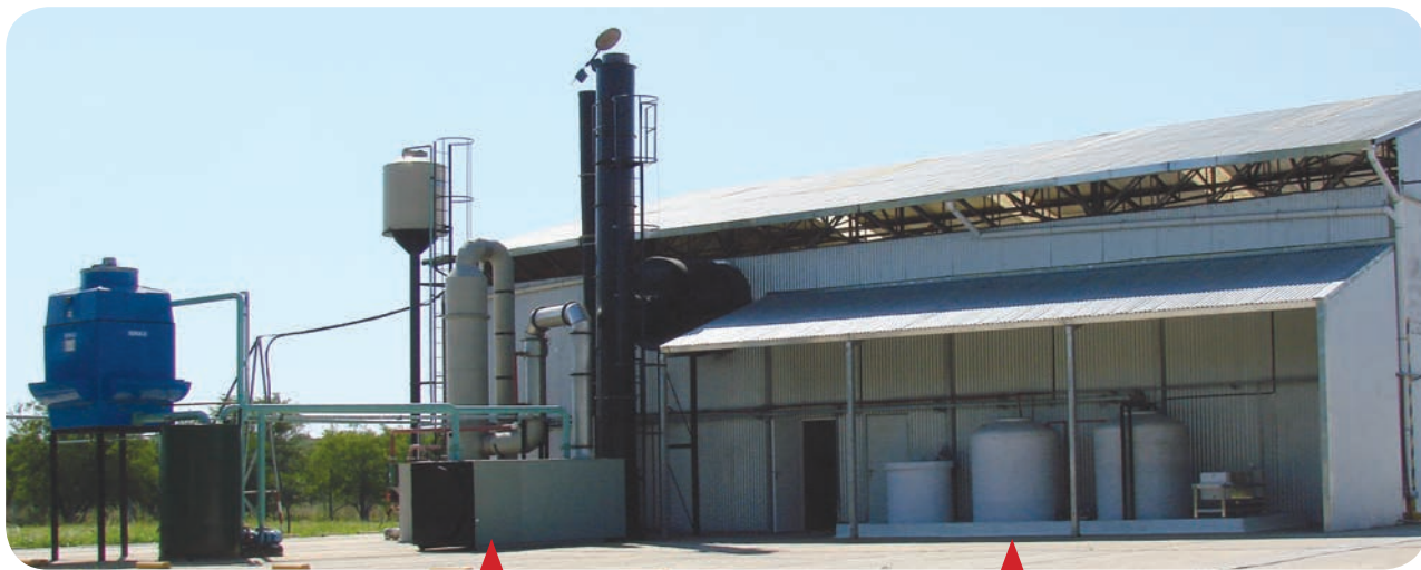
Sector Lavado de Gases
